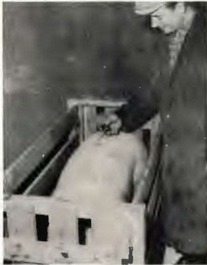
Bild 3: Als Koppelmedium wurde Motorenöl benutzt.
